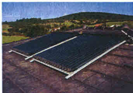
Un chauffe-eau solaire , souvent constitué de tubes parallèles (parfois sous paroi vitrée) dans lesquels circulent un liquide caloporteur.
